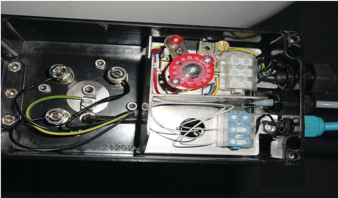
Illustration 4.21: Limiteur de température de sécurité dans le boîtier de raccordement du chauffage
