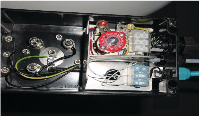
Bild 4.21: Sicherheitstemperaturbegrenzer im Anschlusskasten der Heizung
