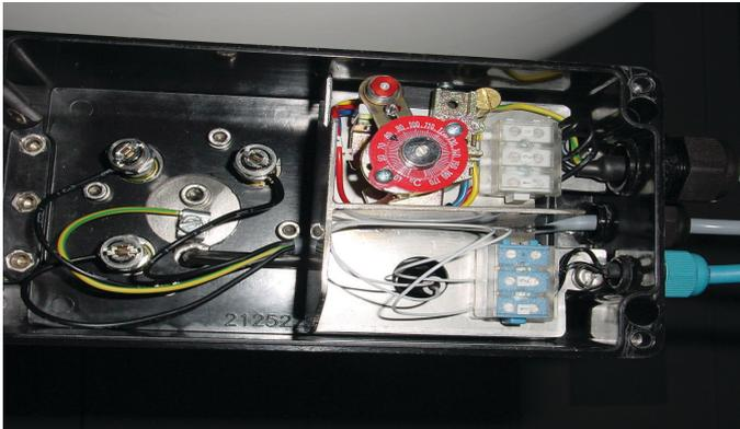
Figura 4.21: Limitador térmico de seguridad en la caja de conexión de la calefacción
