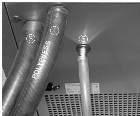
図 5.20：ミニスプレードライヤー B-290 Advanced とイナーナーループ B-295 の閉鎖モード運転のための配管
