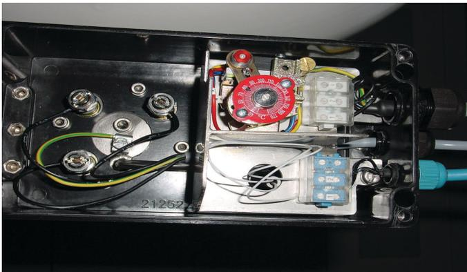
Figura 5.2: Limitador térmico de seguridad en la caja de conexión de la calefacción
